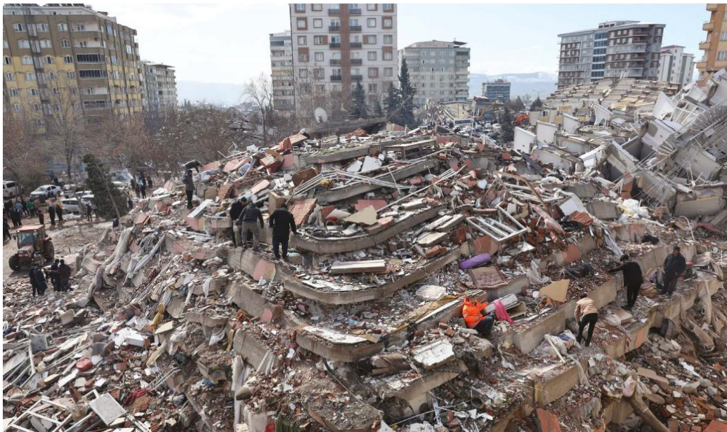
图 1 土耳其地震破坏了很多地方的建筑，如卡赫拉曼马拉什市
